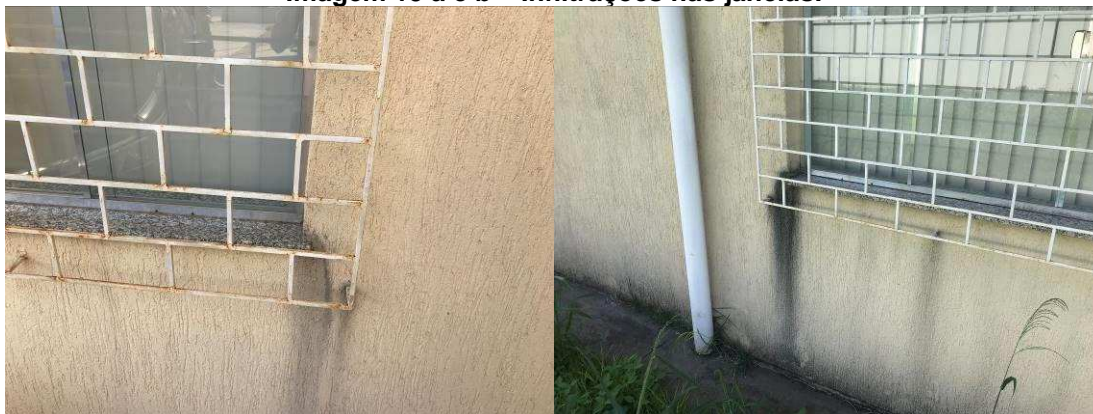
Imagem 15 a e b – Infiltrações nas janelas.
