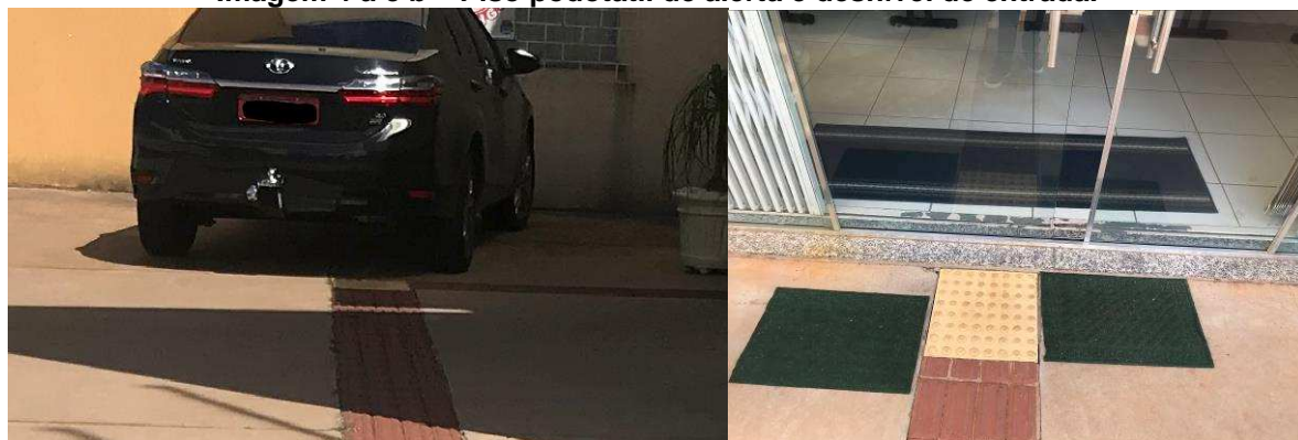
Imagem 4 a e b – Piso podotátil de alerta e desnível de entrada.
